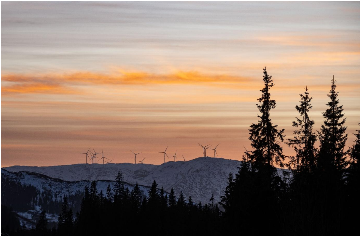
Foto: 29 NVE | Stig Storheil: Øyfjellet vindkraftverk
