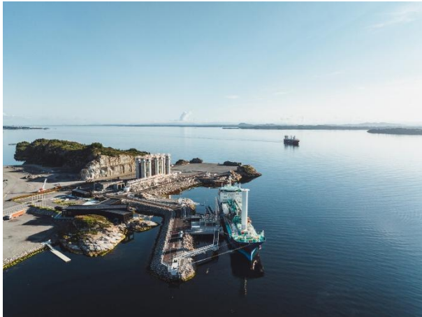
Figur V30. Northern Lights CO 2 terminal i Øygarden som startet å operere sommeren 2025. CO 2 transporteres ved bruk av skip og blir injisert i undergrunnen for permanent lagring. Foto: Ruben Soltvedt, Northern Lights
