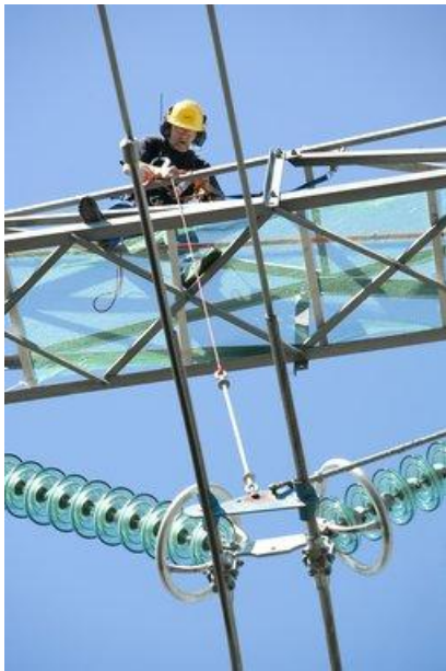
Figur V20. Elektriker som jobber på en høyspentmast. Foto: Sverre Chr. Jarild
