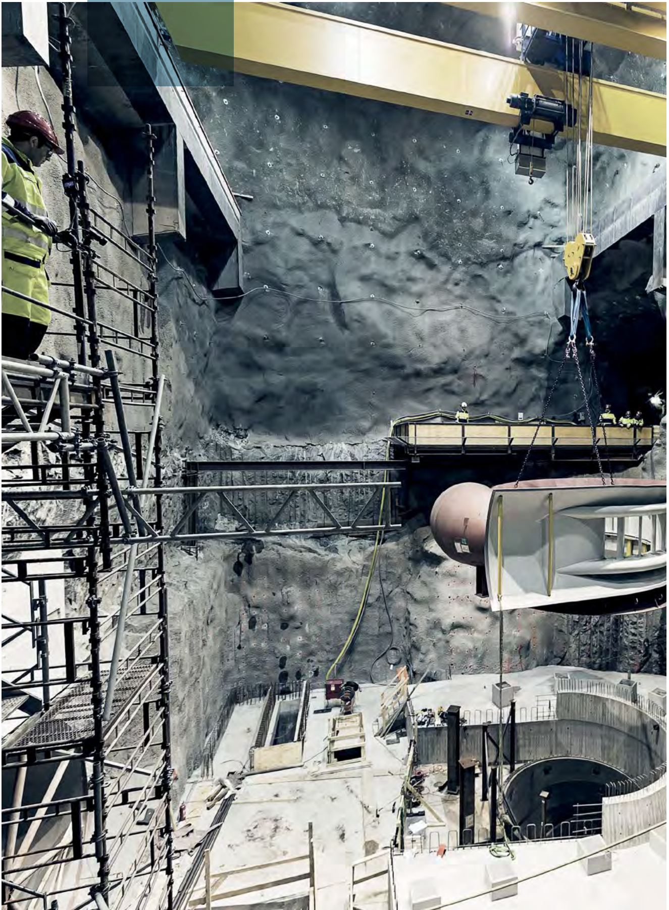
Ny Iveland spiraltrommel. Foto: Agder Energi
