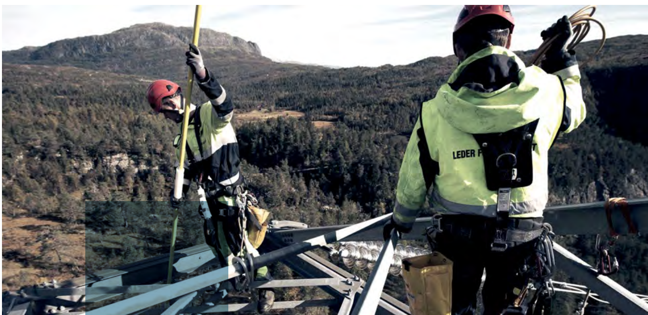
Arbeid på kraftmaster, Statnett. Foto: Johan Wildhagen
