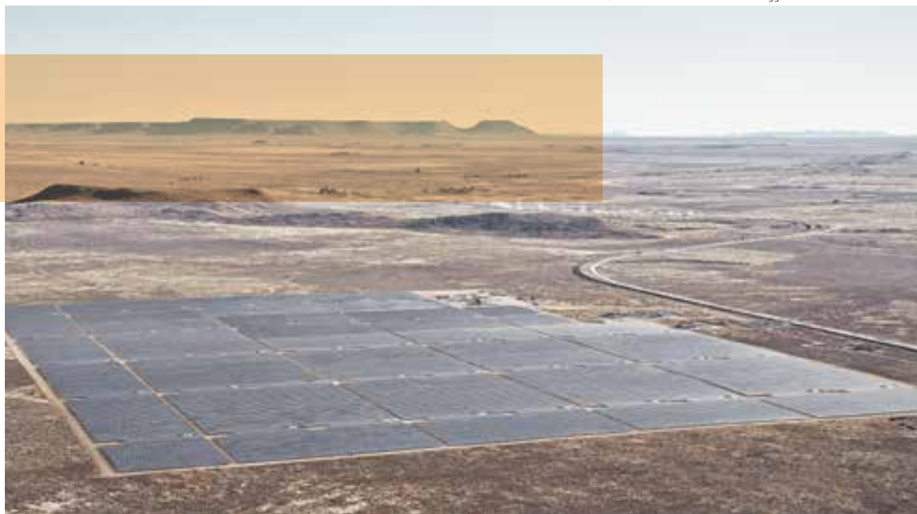
75 MW i Kalkbult, norske Scatec Solars solkraftanlegg i Sør-Afrika. Foto: Scatec Solar
