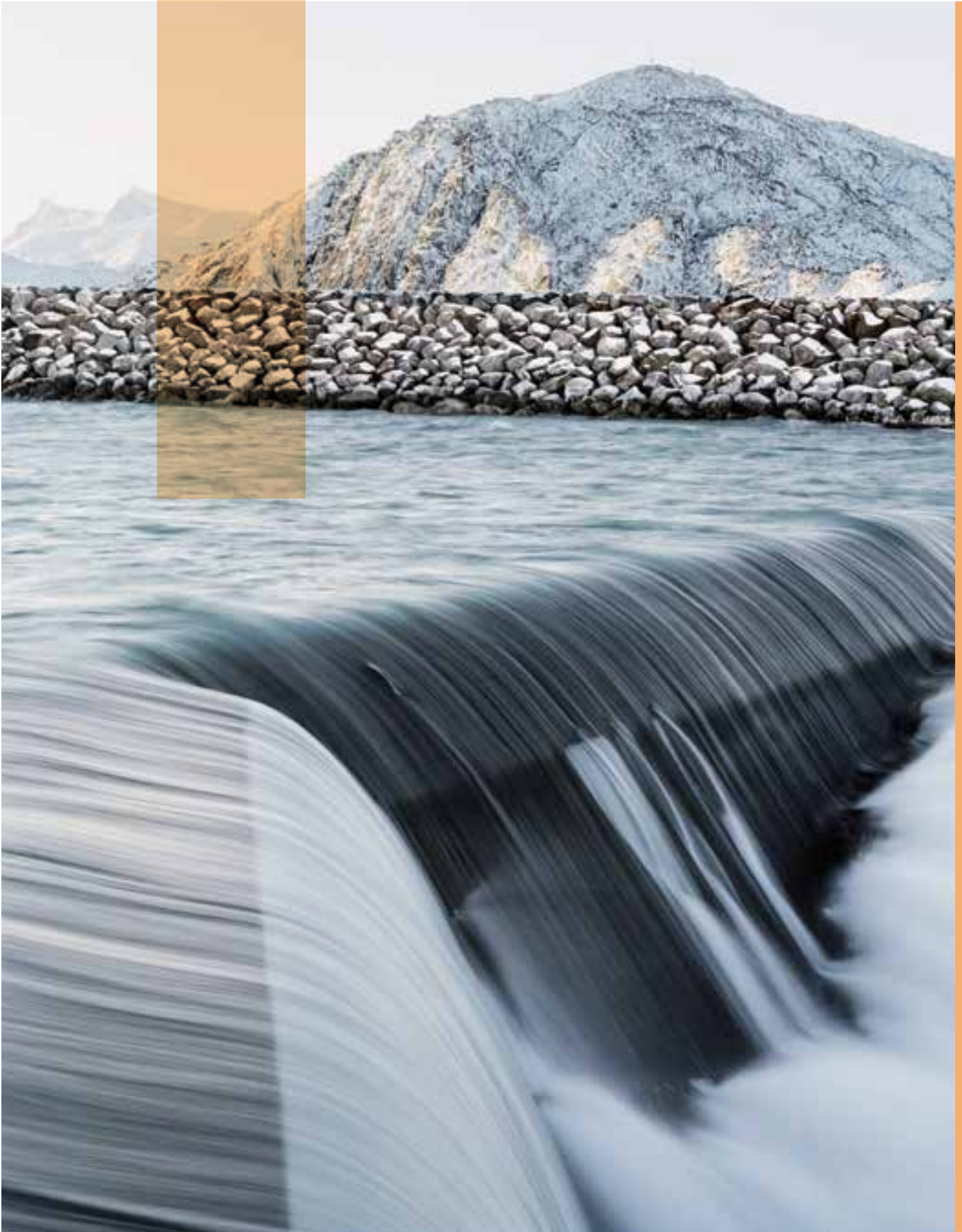
Holmvassdammen, Svartisen kraftstasjon, Statkraft. Foto: Christian Houge
