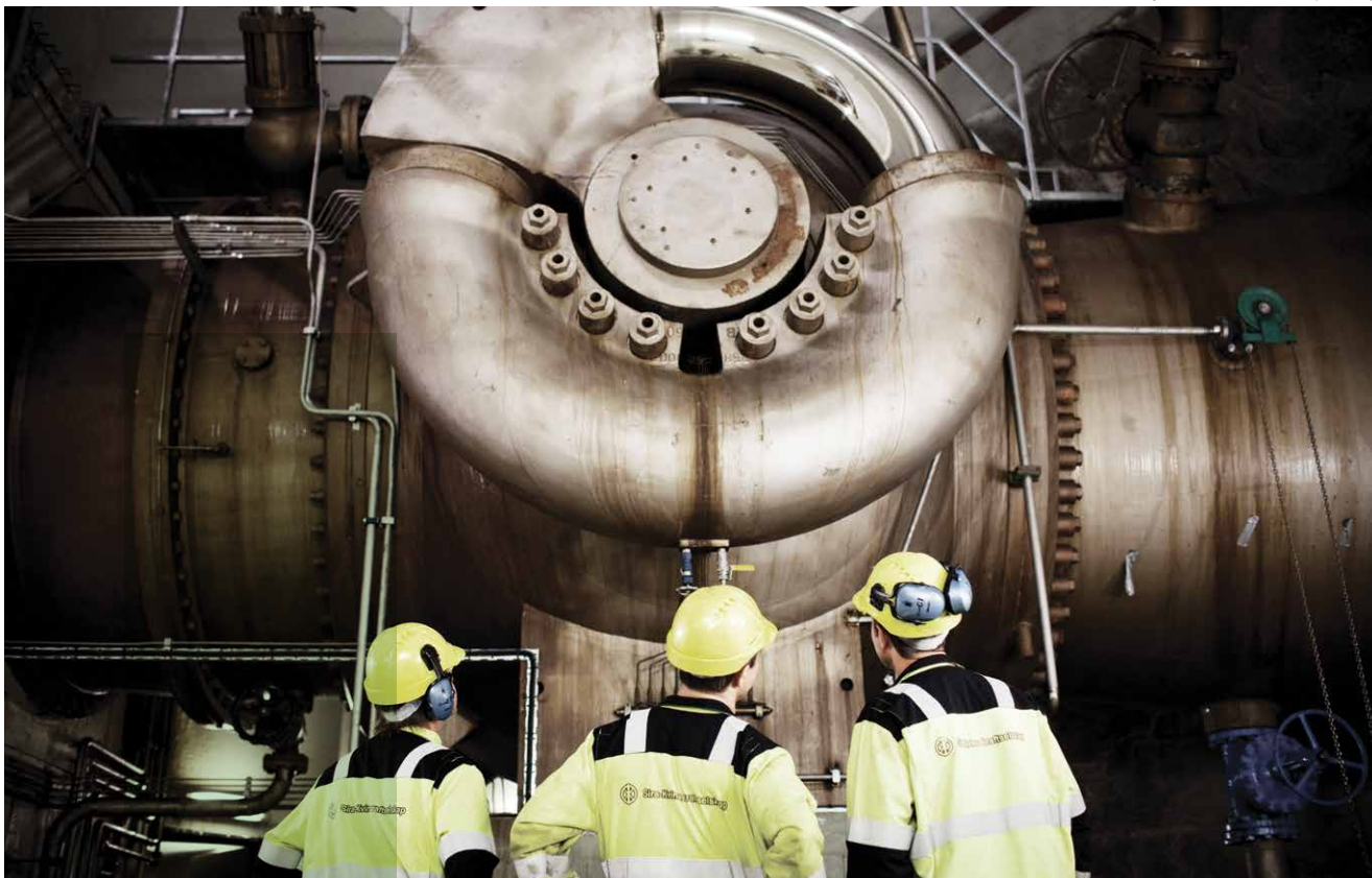
Turbin – Sira Kvina kraftstasjon. Foto: Sira Kvina kraftselskap
