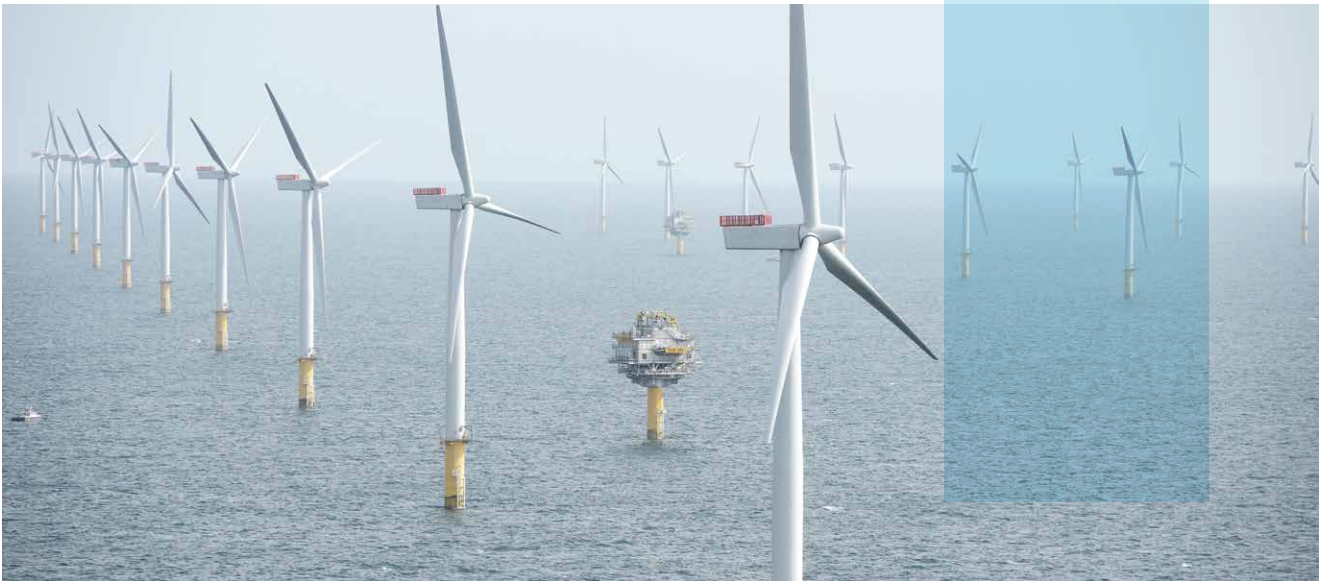
Sherringham Shoal 317 MW offshore vindkraftpark utenfor østkysten av England. Foto: Statoil
