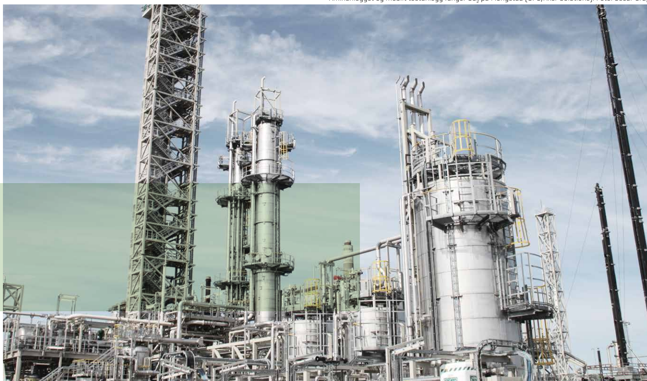
Aminanlegget og mobilt testanlegg fanger CO 2 på Mongstad (OFG/Aker Solutions). Foto: Oscar Graff
