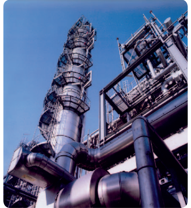
Overskuddsvarme fra prosessanlegg. Foto: Siemens.
