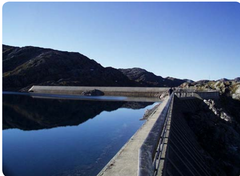
Svartevatn, vannmagasin til Vemundsbøtt kraftverk. Foto: BKK.
