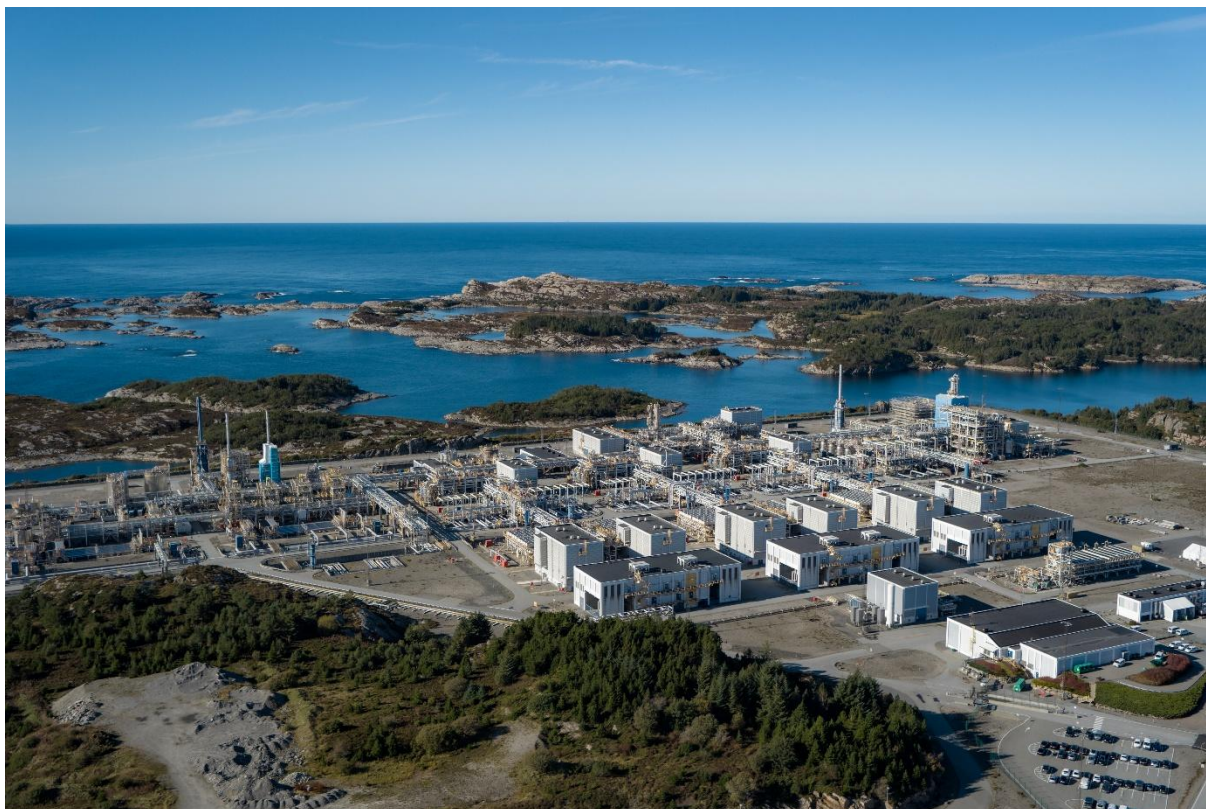
Foto: 3 Gassco – Equinor | Prosessanlegget på Kollsnes i Øygarden er en viktig knutepunkt for Norges energisektor og støtter Europeisk eksport. Kollsnes behandler gassen fra feltene Troll, Kvitebjørn, Visund og Fram.
