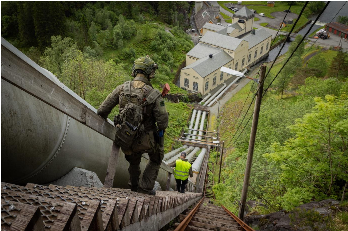
Foto: 32 Forsvaret | Selma Jenvin-Steinsvåg: Øvelse Counter Sabotage - Beskytte/håndtere sabotasje mot kritisk infrastruktur
