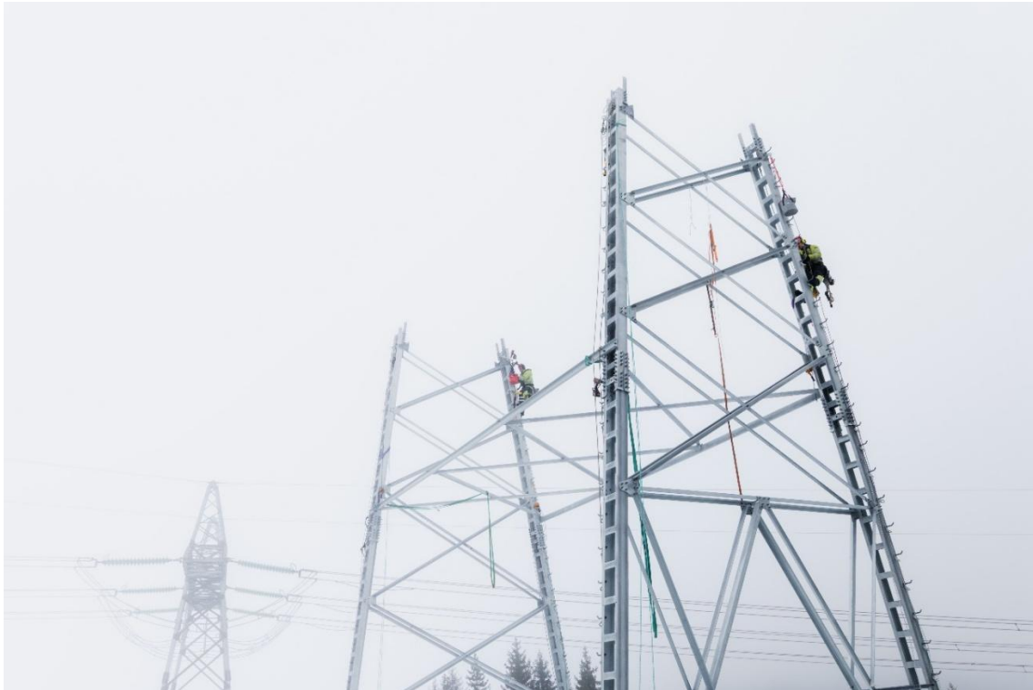
Foto: 14 Statnett | Vetle Hofstad | Liåsen transformatorstasjon fra montasje av master.
